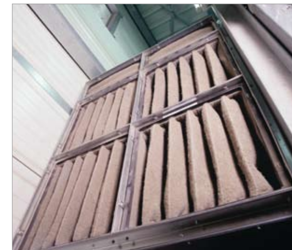
Фильтровальные маты предотвращают проникновение пыли
